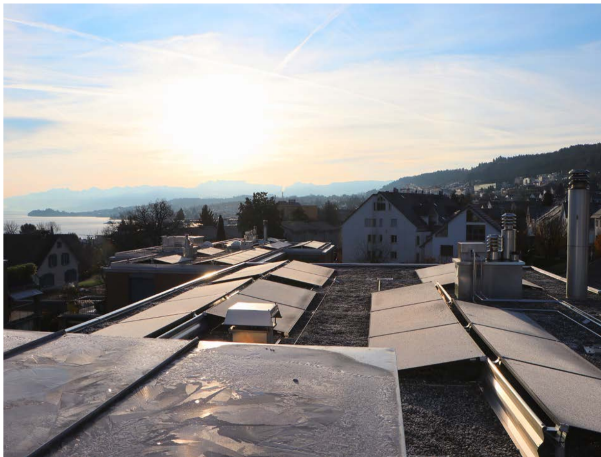
Oben: Auf dem Flachdach der Bleierstrasse 5 füllen die 35 PV-Module rund 68 Quadratmeter Fläche aus und die 12 PVT-Module 23 Quadratmeter. Unten: Das Energiekonzept der beiden Häuser. Unten rechts: Der Soltop-Fachmann instruiert die Eigentümer über die Bedienung der Wärmepumpe. BILDER HEV SCHWEIZ, GRAFIK OIKOS & PARTNER GMBH
